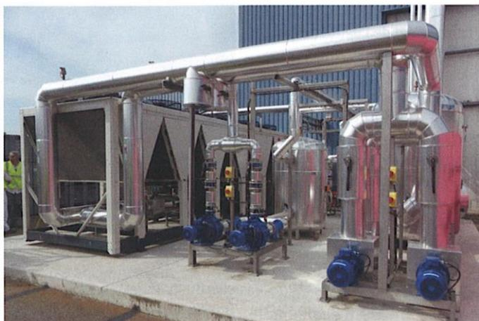
**Blédina (Danone)** a pu installer des pompes de taille inférieure grâce à la faible viscosité du caloporteur biosourcé Greenway Neo et obtenir des gains énergétiques.
