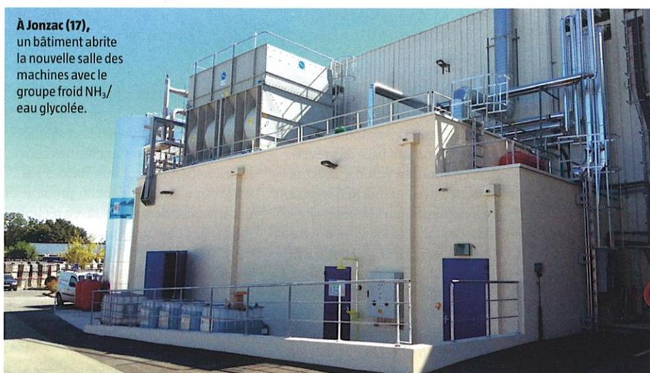
**À Jonzac (17),** un bâtiment abrite la nouvelle salle des machines avec le groupe froid NH<sub>3</sub>/eau glycolée.
